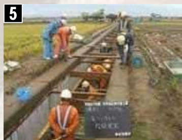
充填コンクリート投入
