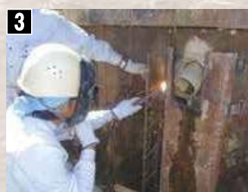
トラス筋溶着
