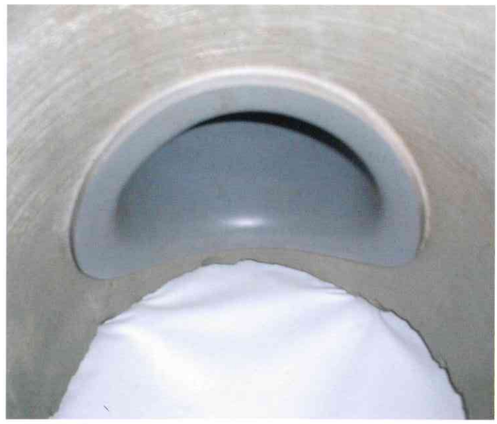
HP250本管へφ150圧着後状況
