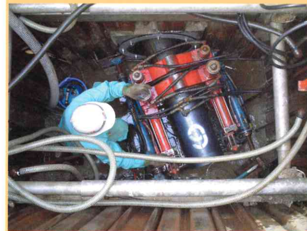
1000×2000mm 開削溝から発進状況
