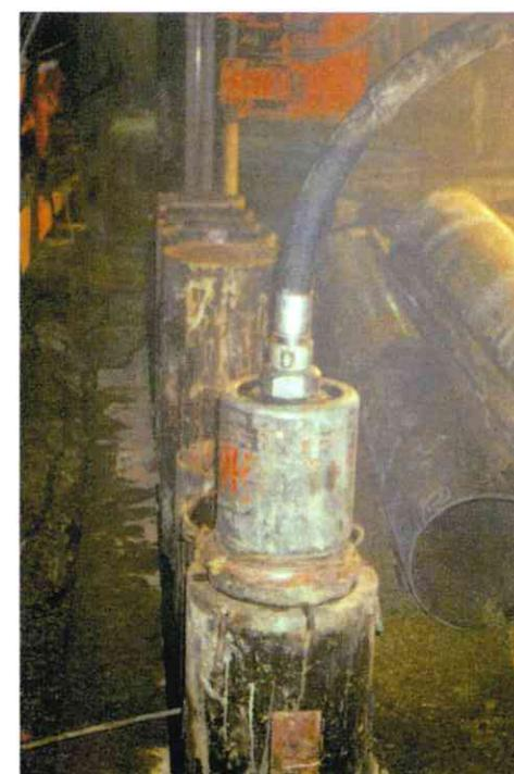
1. 地下室などの上部空間の低い場所で鋼管を打ち込むことができる。
