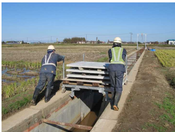
運搬作業状況
