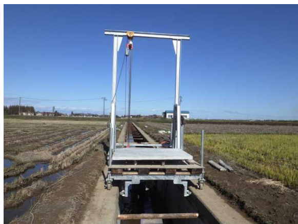
設置状況(全景)
