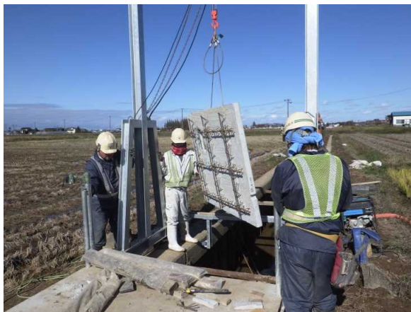
吊上げ作業状況
