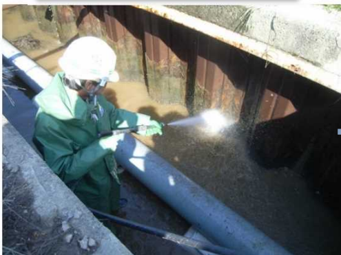
下地処理工 (高圧洗浄)
