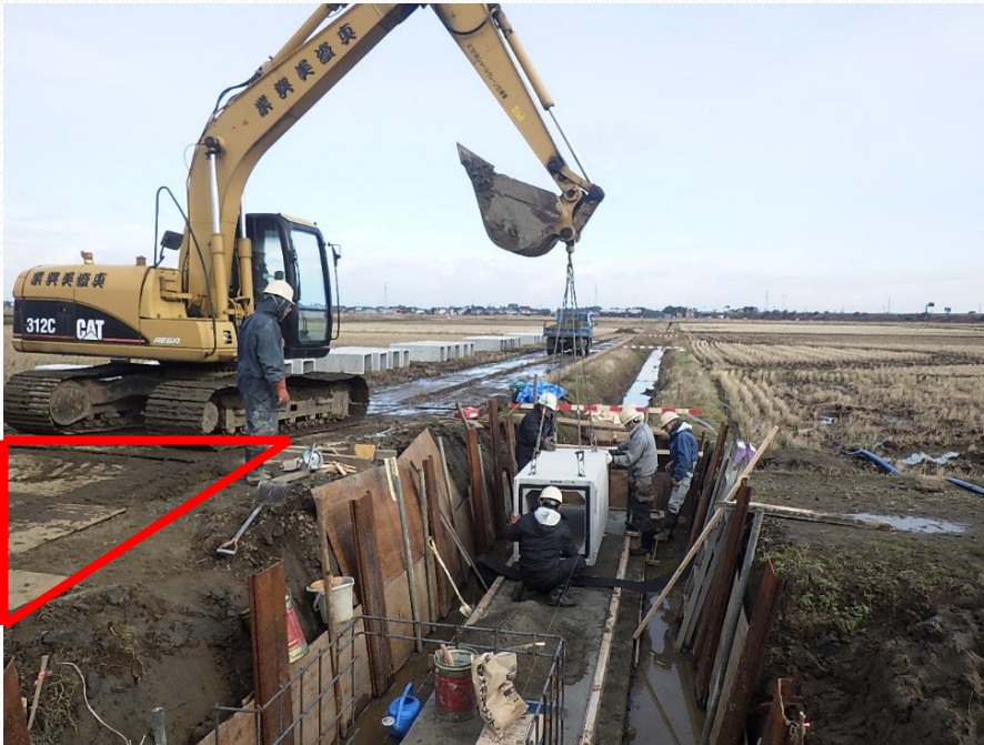
従来技術「敷鉄板・仮設道路による重機作業」
