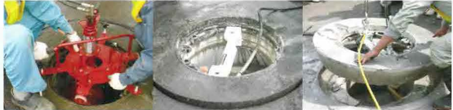
4-a 内径切断機で緊結ボルトをカット、スプリッターで分離し、吊り上げ撤去
