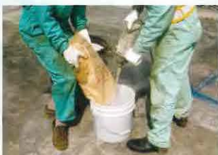
9 モルタルの攪拌
