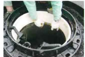
8 内型枠をセット
