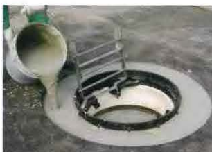
10 モルタル打設
