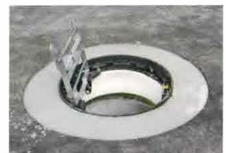
11 モルタル硬化まで養生
