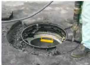
4-b 破碎による撤去
