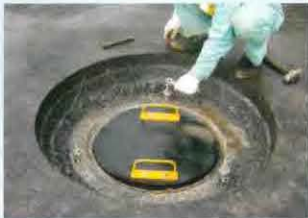
6 後施工アンカー
